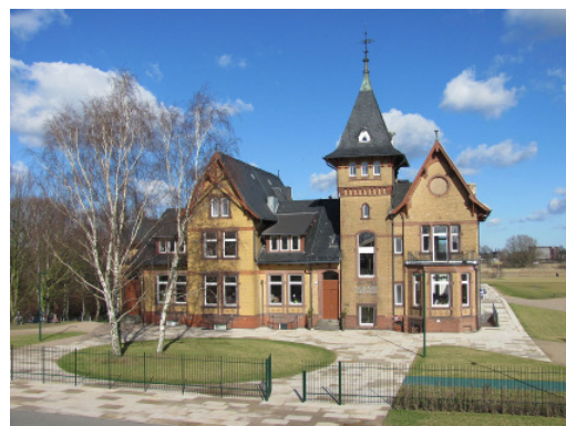
Villa Kaltehofe, bis 1990 Hygienisches Institut
